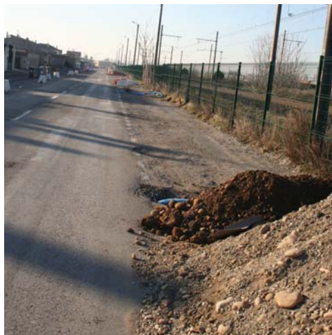
Tout le long de la ligne ferroviaire, une piste cyclable
