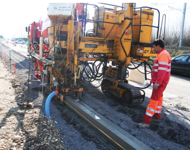
La pose des bordures
